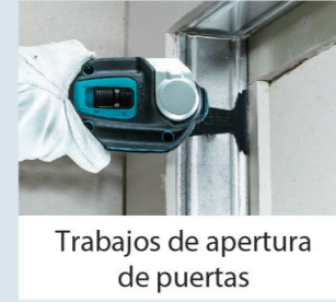
Trabajos de apertura de puertas
