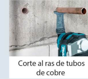
Corte al ras de tubos de cobre
