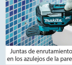
Jointas de enrutamiento en los azulejos de la pared
